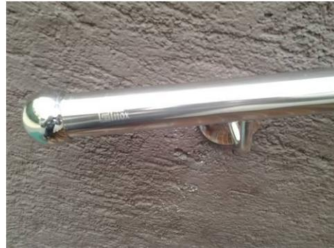
Edelestahl V2A Rundrohr Ø40mm,
