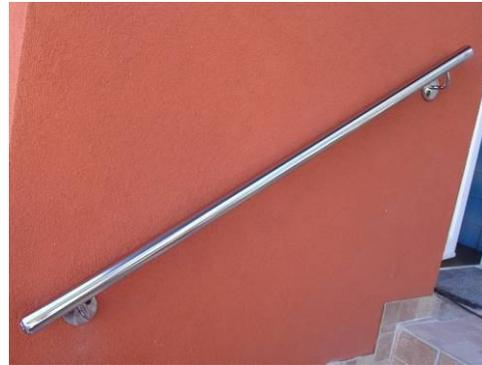
Edelestahl V2A Rundrohr Ø40mm,
